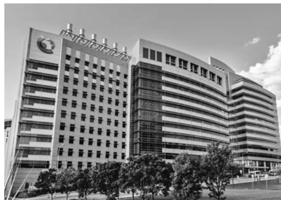
写真1 筆者の研究室がある研究棟の外観
